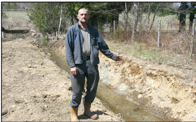
Exaspéré par des inondations printanières et s'estimant dans son droit, M. Sylvain Lafond a entrepris des travaux sans autorisation de la municipalité de Dudswell.
